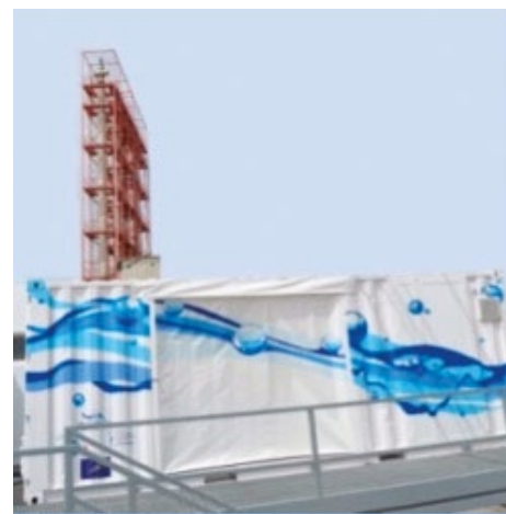
Figura 1: La planta piloto de Destilerías Muñoz Gálvez
